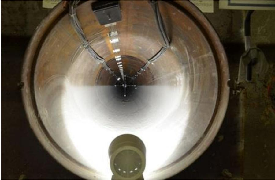
Les déchets MH-VL seront entreposés dans des cylindres en inox puis dans des cubes en béton, stockés dans des galeries. Les déchets HA, qui arriveront aussi dans des cylindres en inox, seront poussés dans des alvéoles de 70 cm de diamètre et d'une centaine de mètres de long. Tout cela grâce à un système d'automates.
